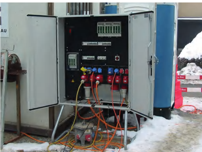
Distributore principale in cantiere
