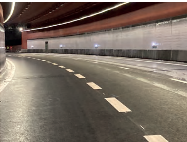
Mariefholmstunnel Göteborg Schweden
