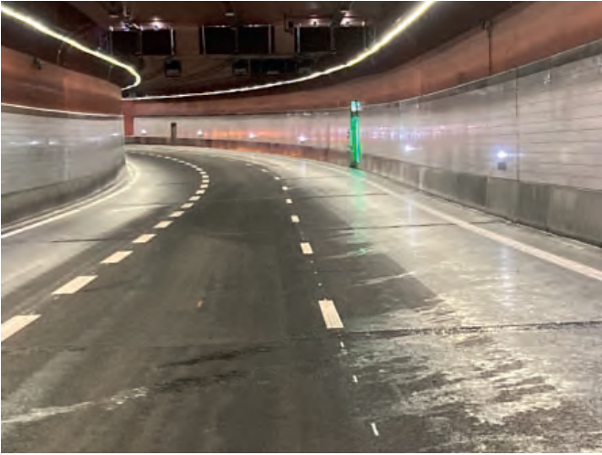
Mariefholmstunnel Göteborg Schweden
