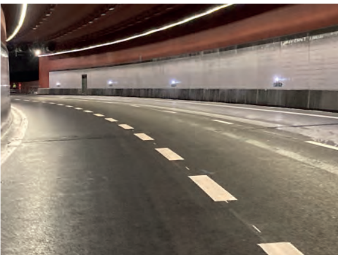
Mariefholmstunnel Göteborg Schweden
