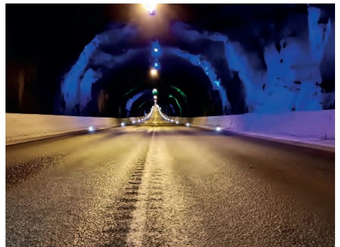
Tunnel lighting Nordoyatunnel Färöer
