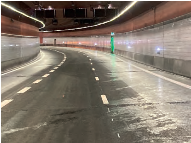
Mariefholmstunnel Göteborg Schweden
