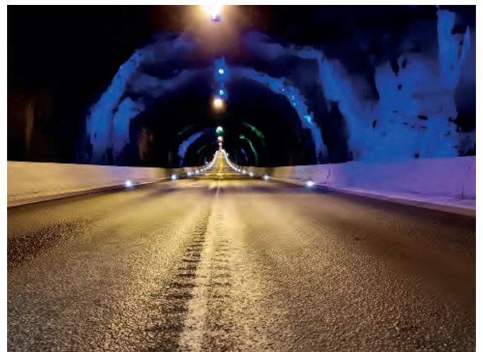
Tunnelbeleuchtung Nordoyatunnel Färöer
