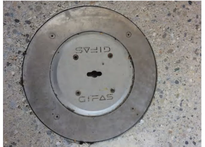
Sol en béton
