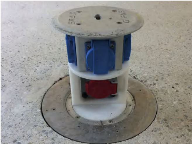
Sol en béton
