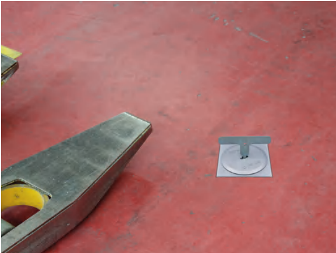
Halle de stockage
