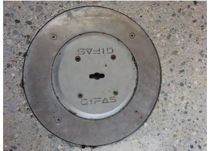
Pavimento in cemento
