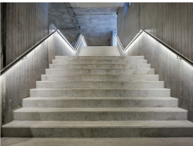
Stazione Le Châble
